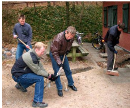
De sidste forberedelser for indvielsen. Hullet foran døren skulle dækkes til, og det er sin sag, når jorden er stivfrossen
