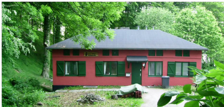
Det facaderenoverede og nymalede klubhus.
